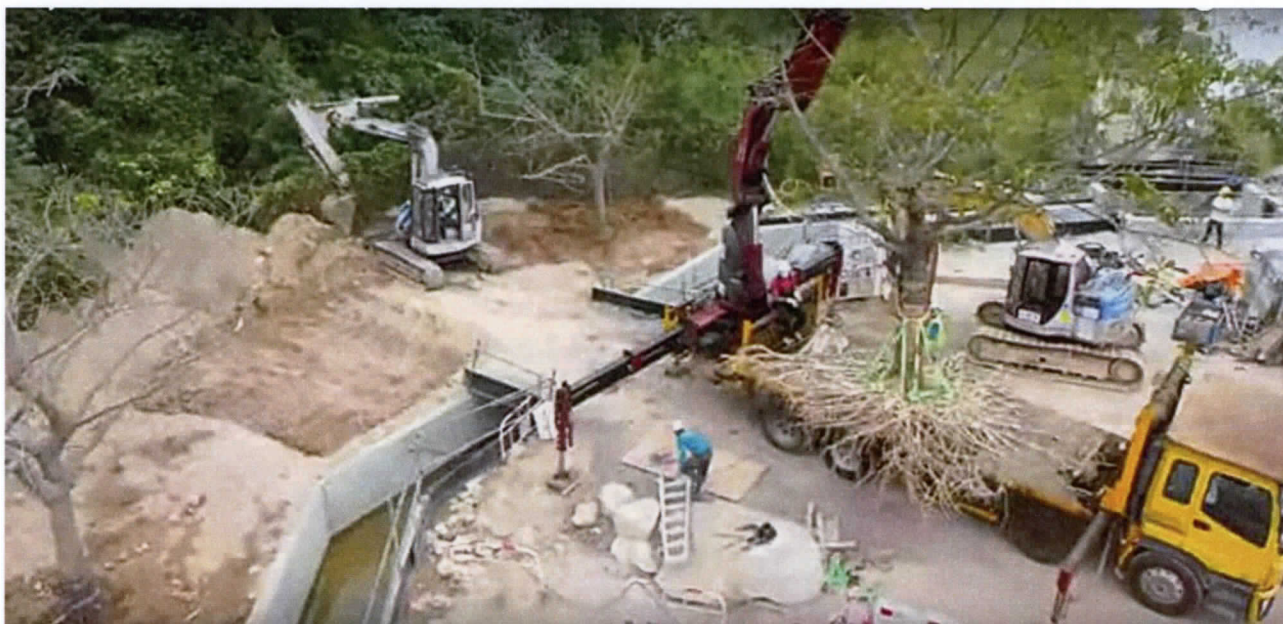
Zdjęcie nr 22. Przenoszenie drzewa, przygotowanego do przesadzenia metodą AirSpade, w miejsce nasadzenia. (Źródło: Asia Tree Preservation, Ltd.)
