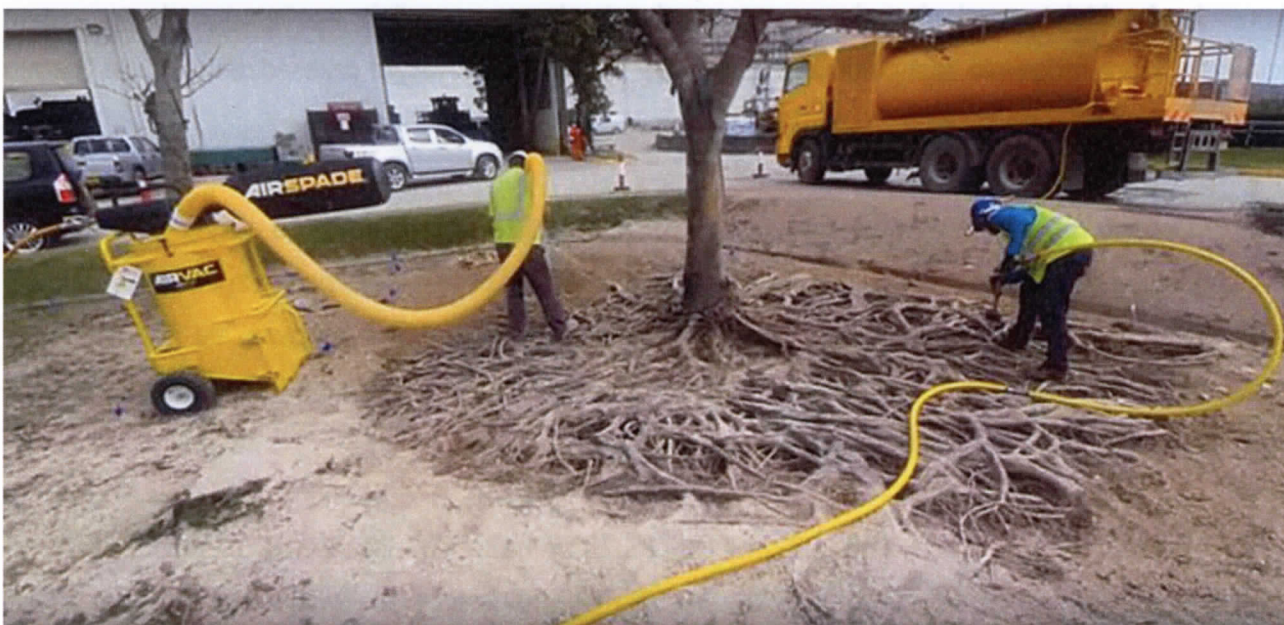
Zdjęcie nr 21. Przygotowanie bryły korzeniowej do przesadzenia z użyciem Airspade (Źródło: Asia Tree Preservation, Ltd.)
